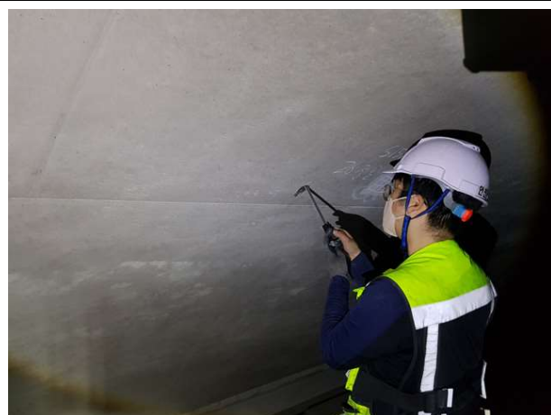
탄산화 깊이 측정
