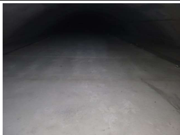
풍도슬래브 상면 S48 상태양호
