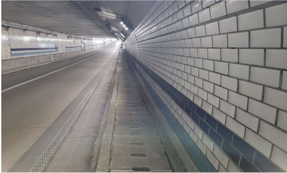
NATM구간 공동구 전경
