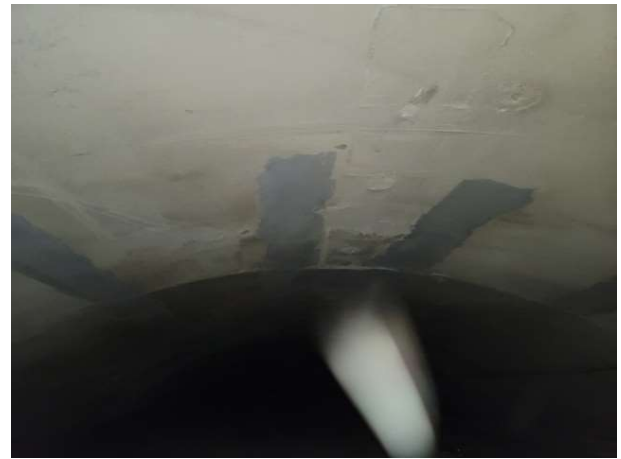
NATM구간 천단부 S50 상태양호
