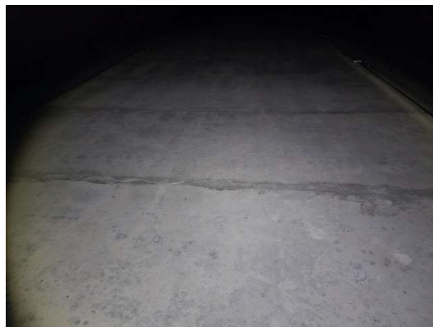
풍도슬래브 상면 S50 상태양호
