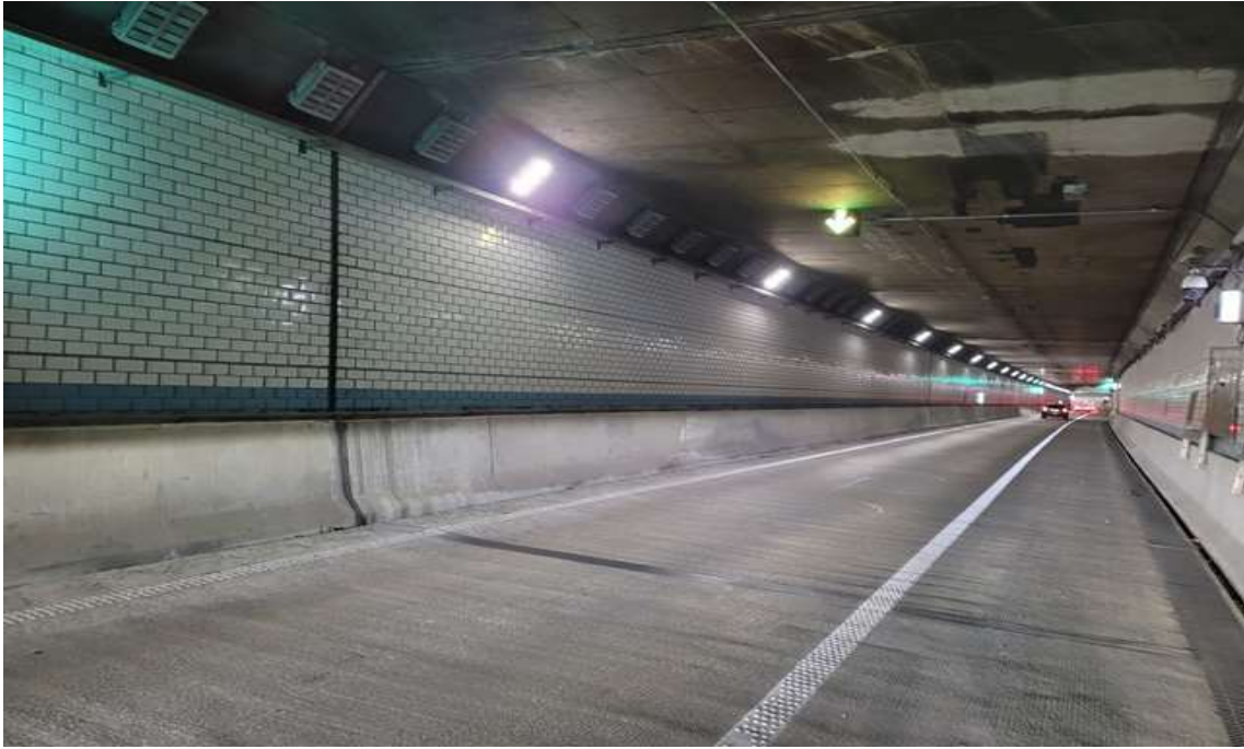
BOX구간 벽체 전경
