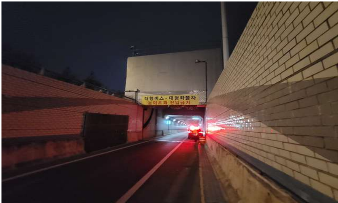
Ramp-D 갭문 진입부 전경
