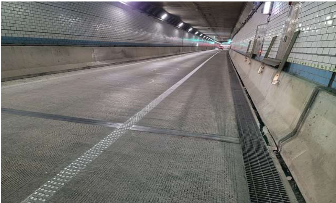
BOX구간 포장 전경
