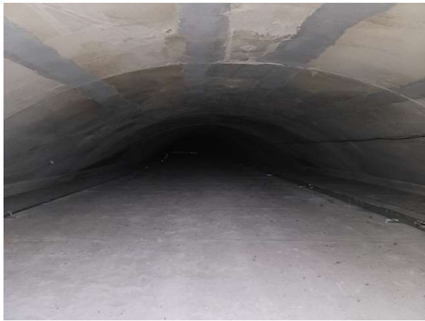
NATM구간 천단부 S54 상태양호
