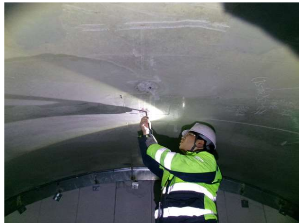
탄산화 깊이 측정
